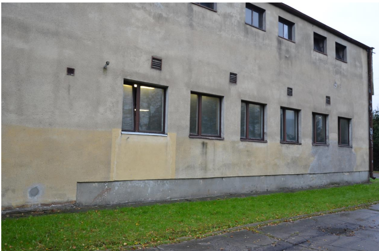
Ściana zewnętrzna przeznaczona do wykucia otworu montażowego
